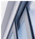
Montage unter dem Sturz.
