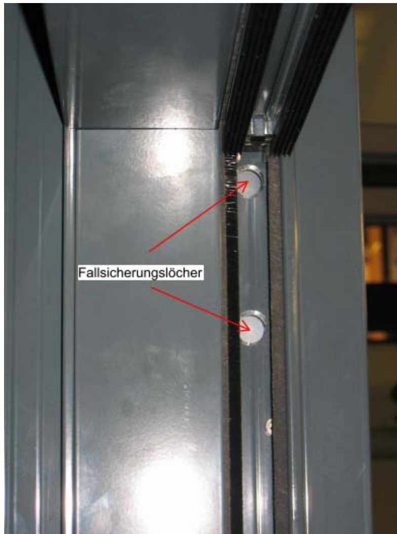
seitliche Verschraubung durch Fallsicherungslöcher
