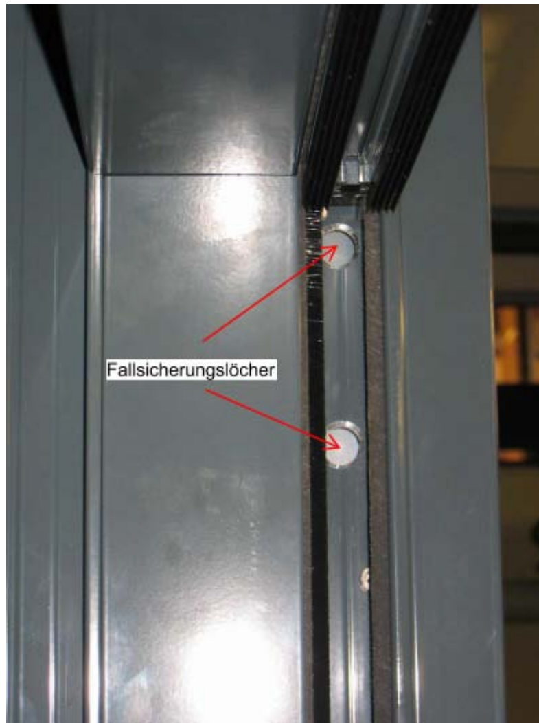
seitliche Verschraubung durch Fallsicherungslöcher
